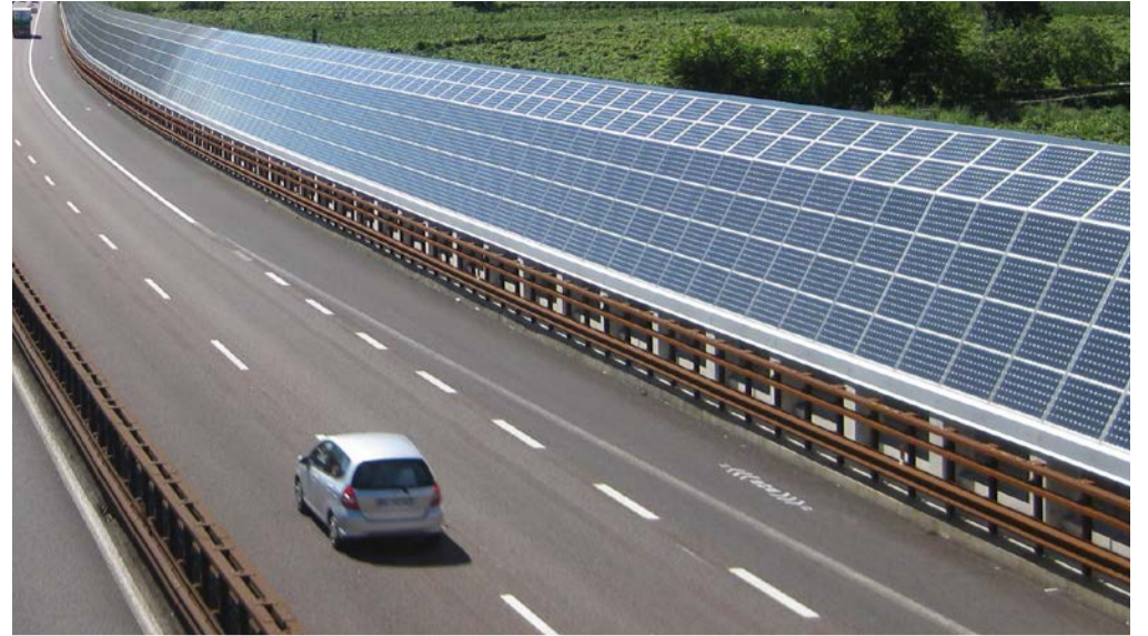
Zonnepanelen verwerkt in een geluidsscherm
