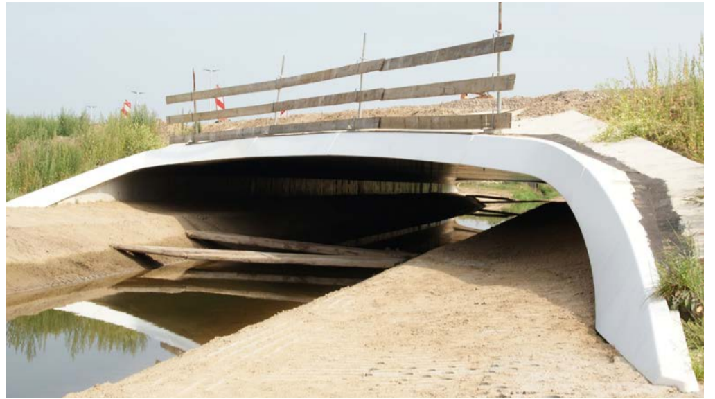
faunapassages langs onderdoorgaande watergangen
