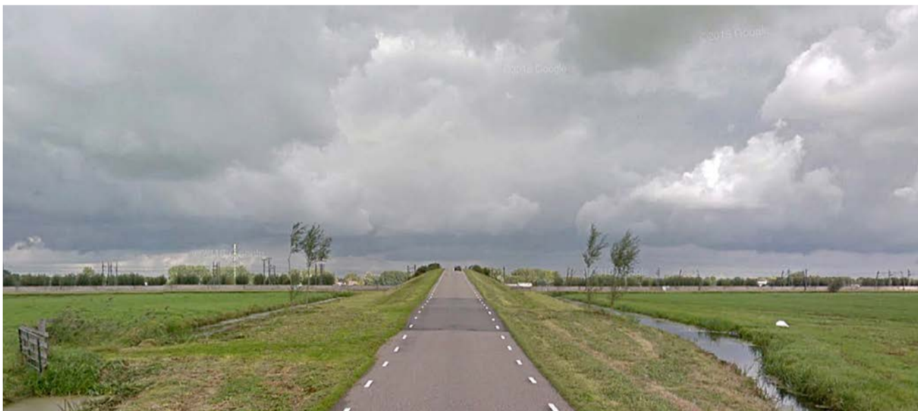
Referentie: simpele viaducten met grastaluds langs de Betuweroute ter hoogte van Polderweg, Giessendam
