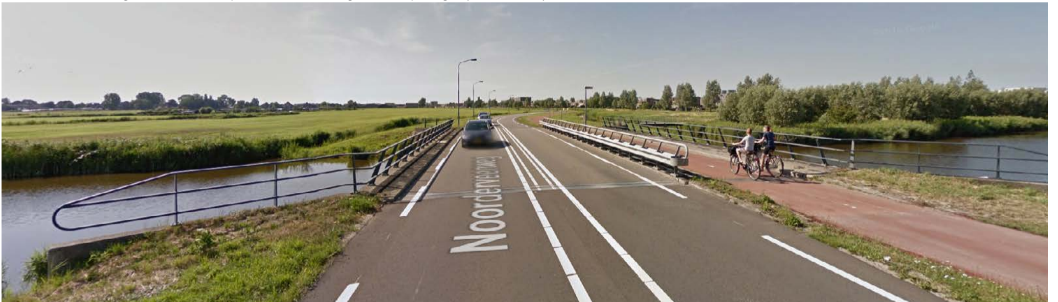
Referentie voor een brugdek over de waterlopen: huidige brugdek van de Noorderveenweg over de Binnendelft
